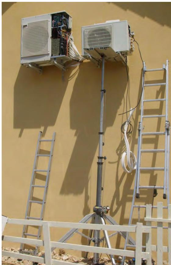
UPTER élévateur électrique portable permet la mise en hauteur de toute charge lourde en toute sécurité.
